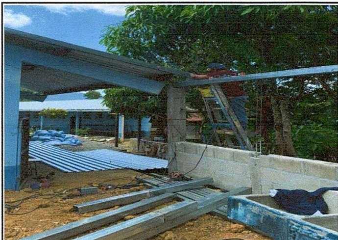
Foto1: Mejoramiento con estructura tipo pórtico e instalación de lámina troquelada calibre 26 en la cocina.
